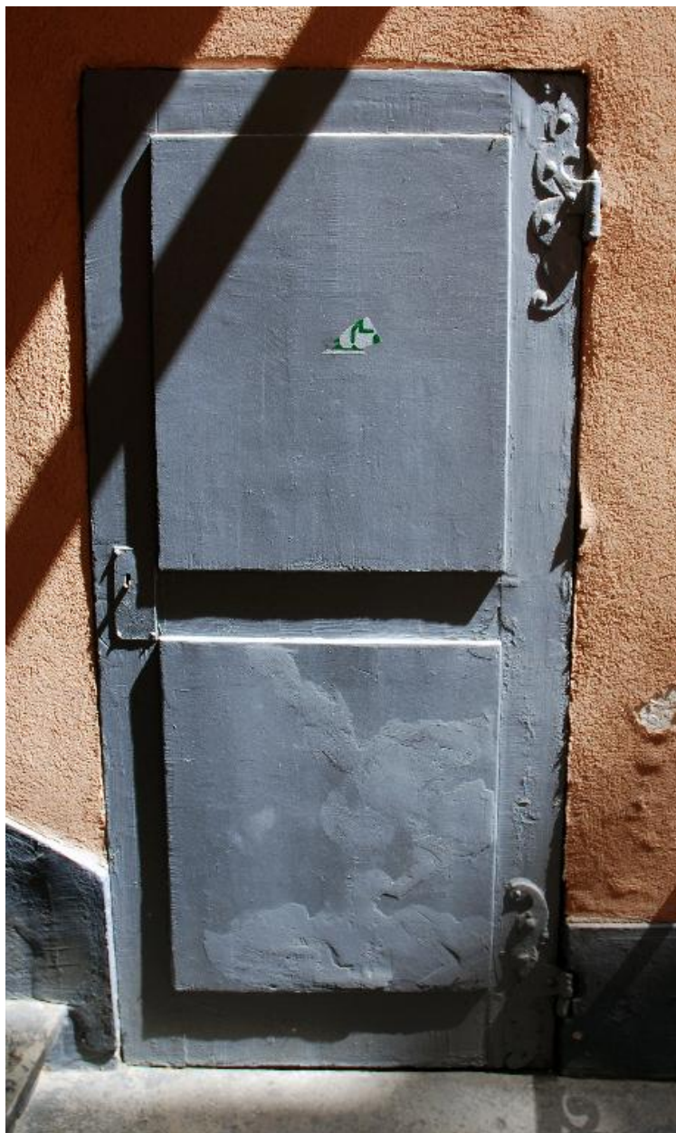
Détail : porte sur le troisième palier
