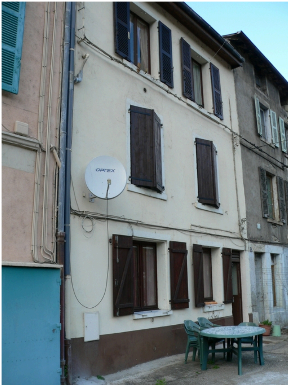
Façade principale sur rue
