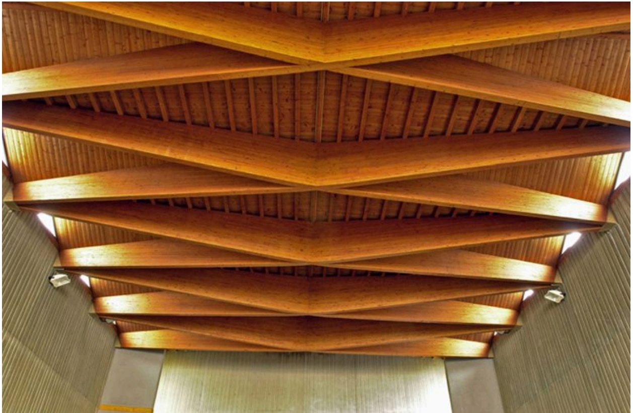
Vue de la charpente apparente
