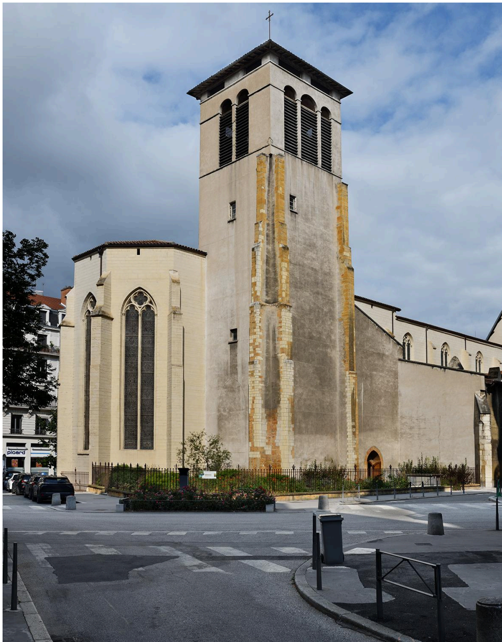
Chevet et clocher depuis la rue Saint-Bonaventure (partie est)
