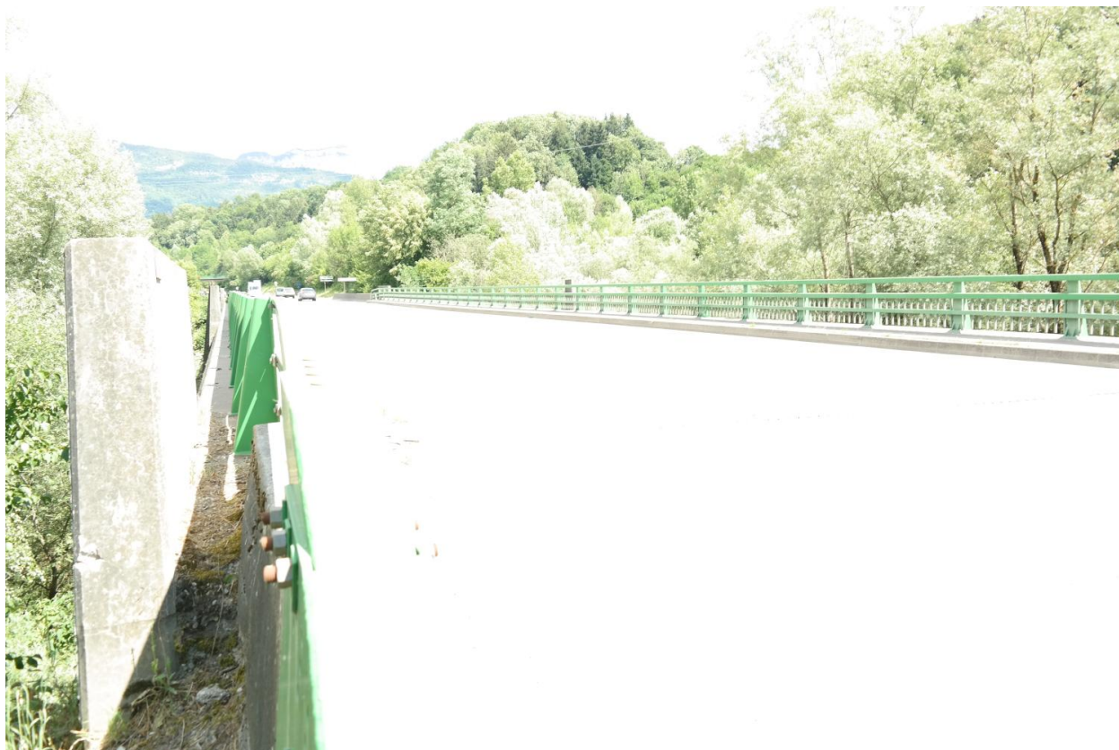
Pont sur le Fier, vue de la chaussée
