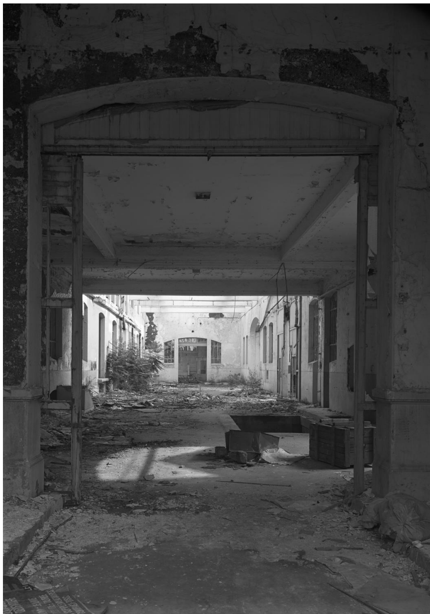
Usine Serseg avant démolition en 1987
