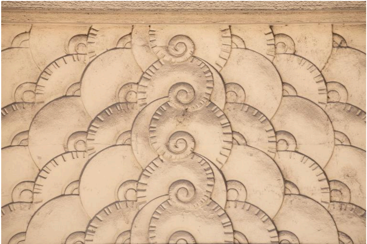
Entrée de l'immeuble : détail du motif central situé au-dessus de la porte
