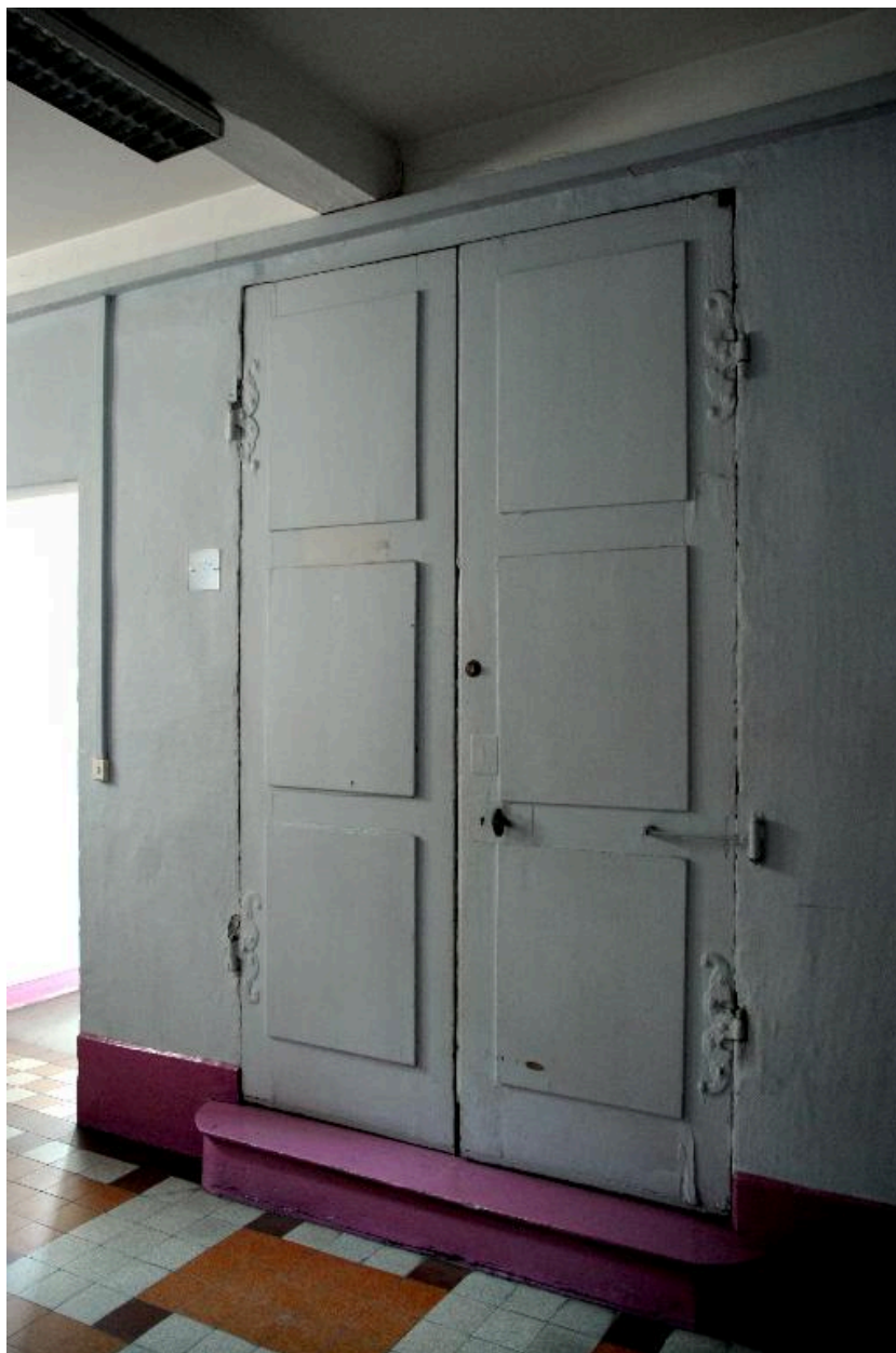
Cour d'honneur, corps de bâtiment est, 3e étage, porte d'accès au comble
