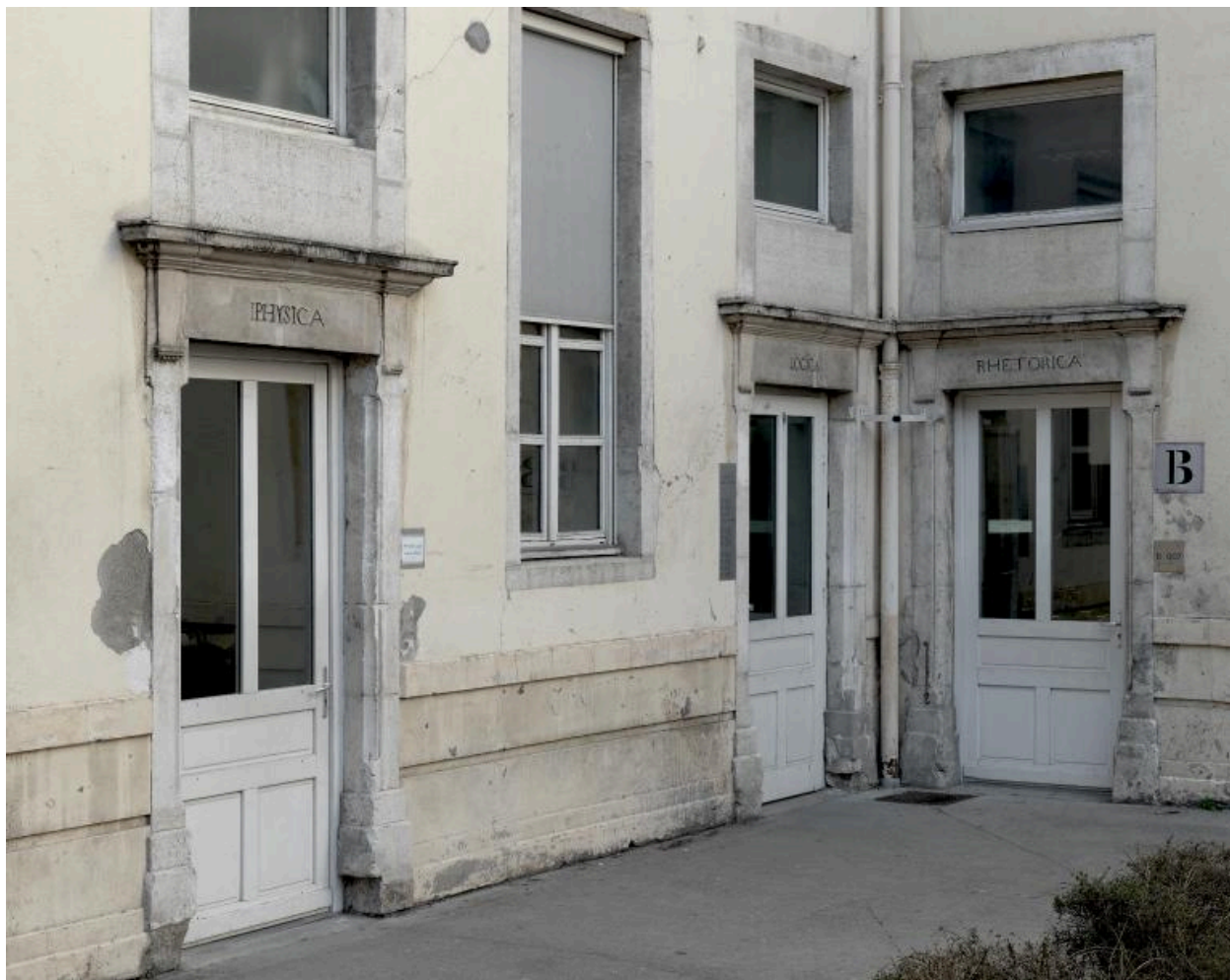
Cour, angle nord-ouest : détail de trois portes de classes portant les inscriptions PHYSICA, LOGICA et RHETORICA
