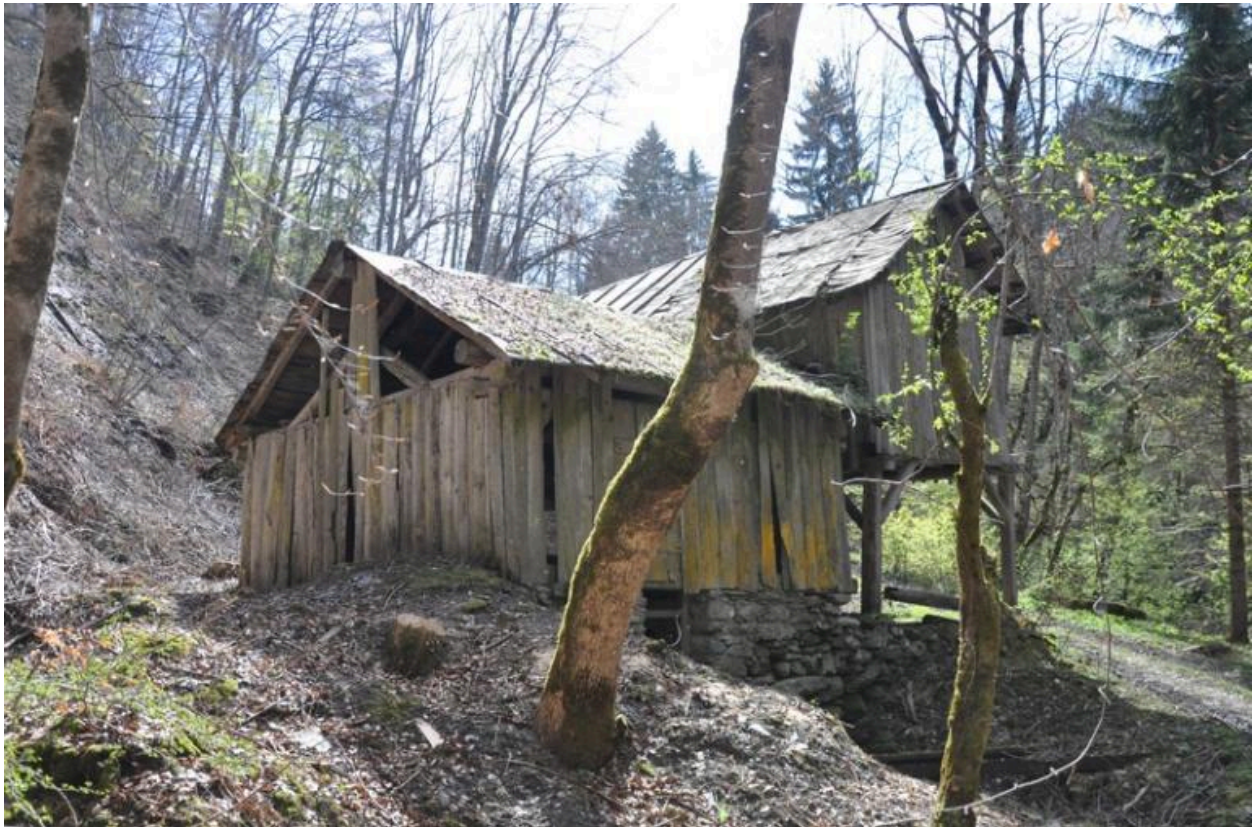
Vue du bâtiment avant sa restauration, 2014.
