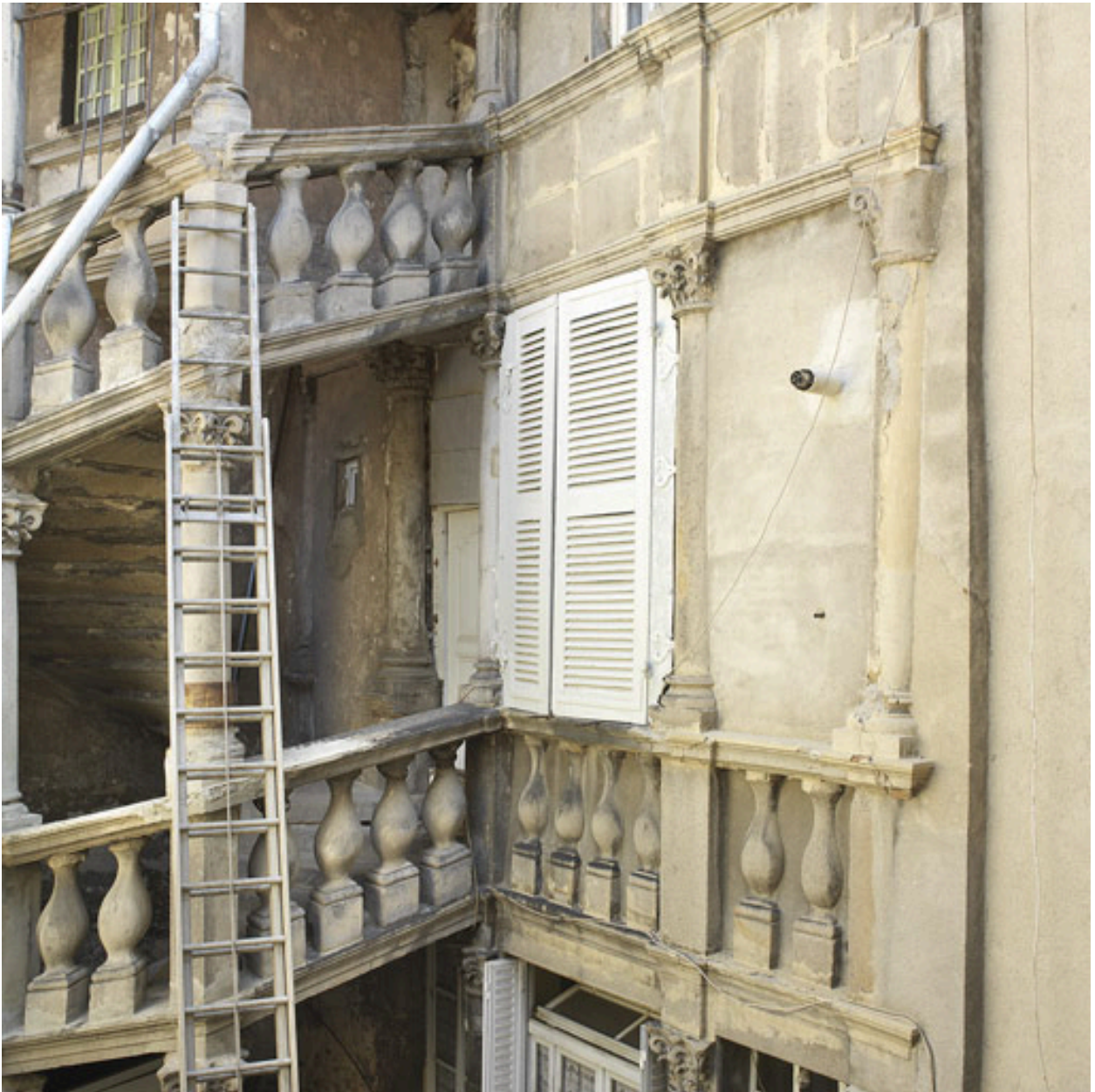
Vue partielle : 1er étage sur cour. Ancienne galerie haute ouverte.
