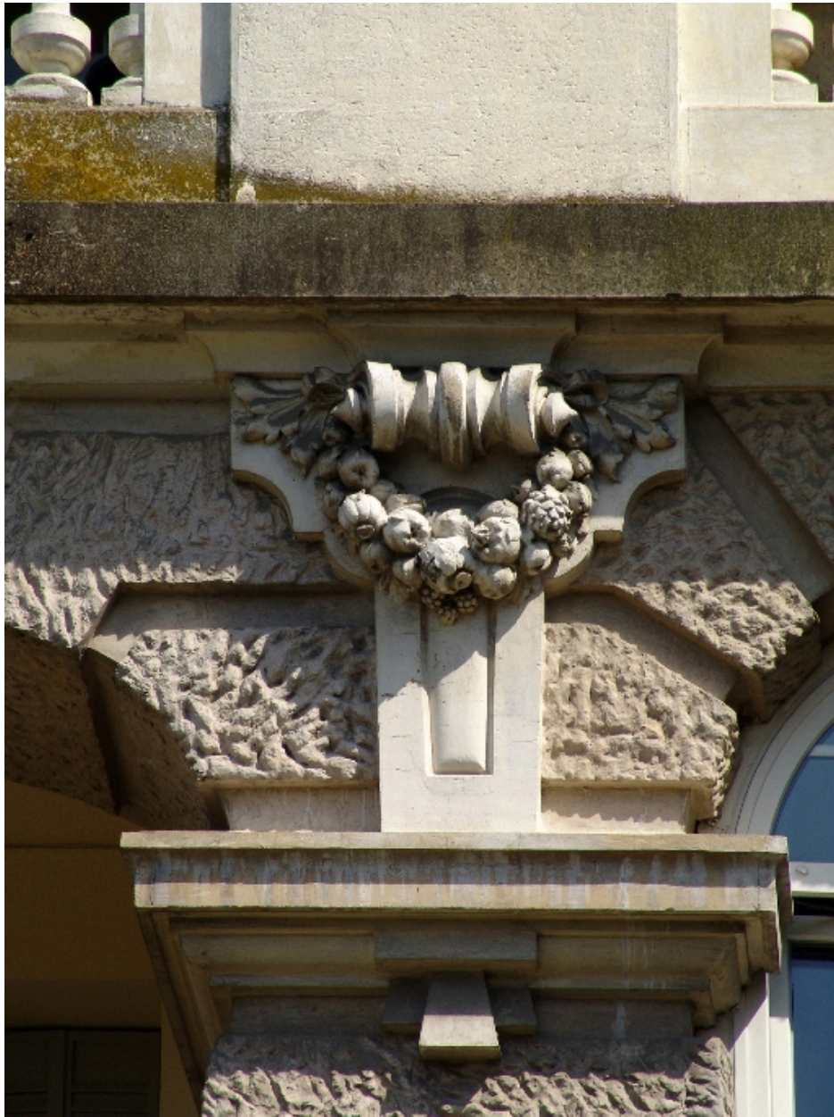
Façade nord-ouest : décor
