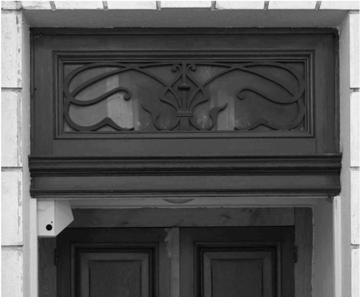
Porte latérale ouvrant sur la rue Boileau : détail du châssis de tympan
