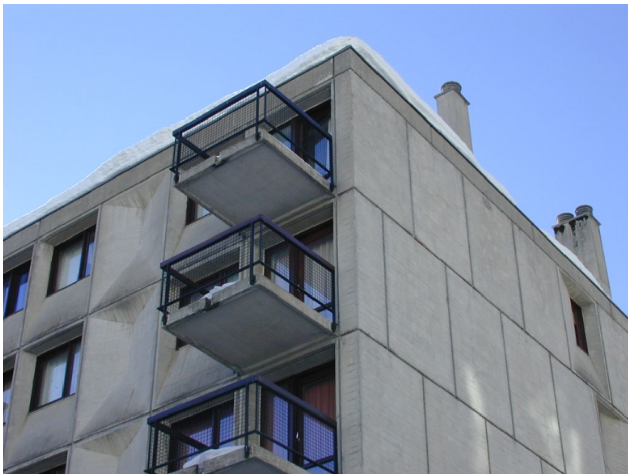
Détail des balcons
