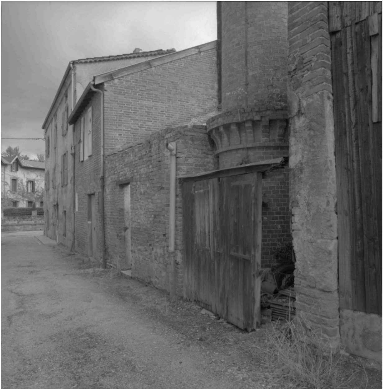
Vue partielle extérieure du local abritant la cheminée pour la blanchisserie de l'établissement.
