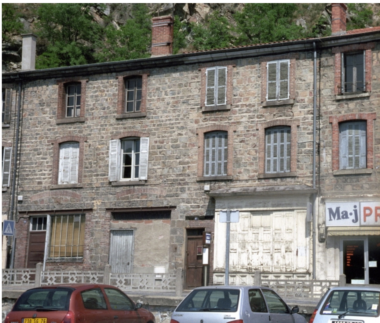
Boën, îlot 17, Lyon (rue de) 87 et 85. Vue générale de la façade sur rue.
