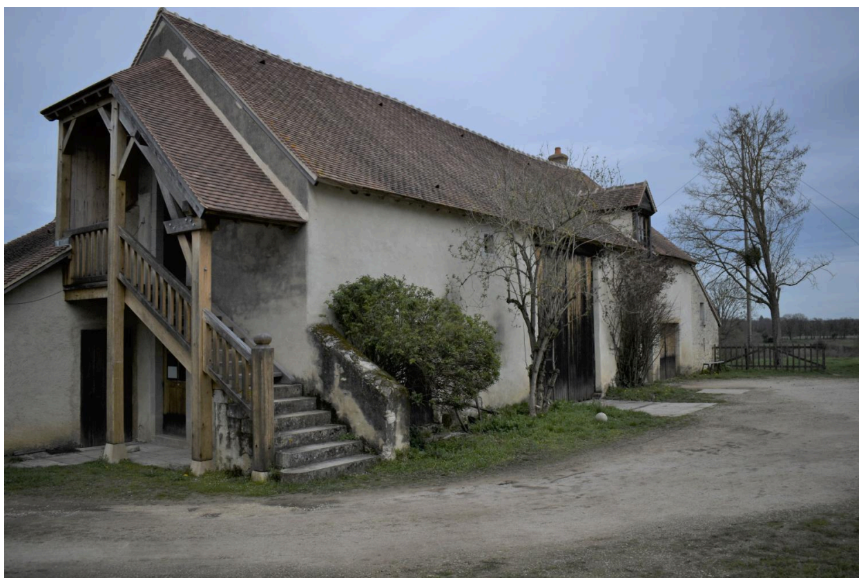
Vue de la grange vers l'est.
