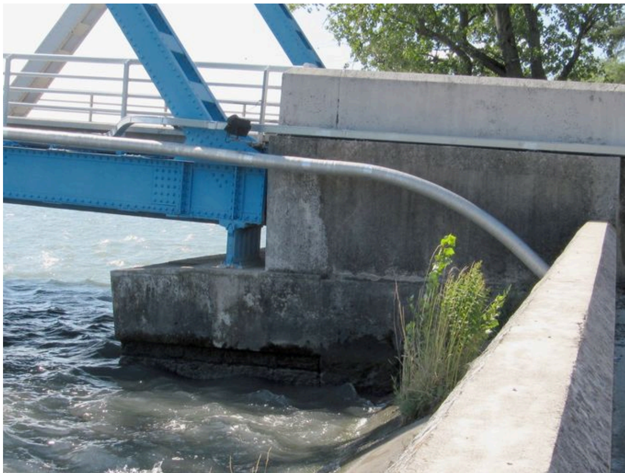
Culée droite, face amont, vue partielle : jonction avec le tablier (depuis la rive droite)
