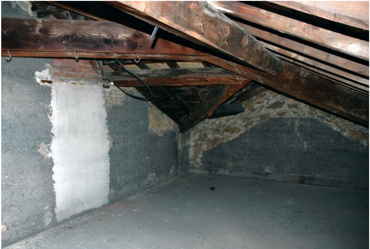
Bâtiment de la galerie, comble de l'avant-corps est
