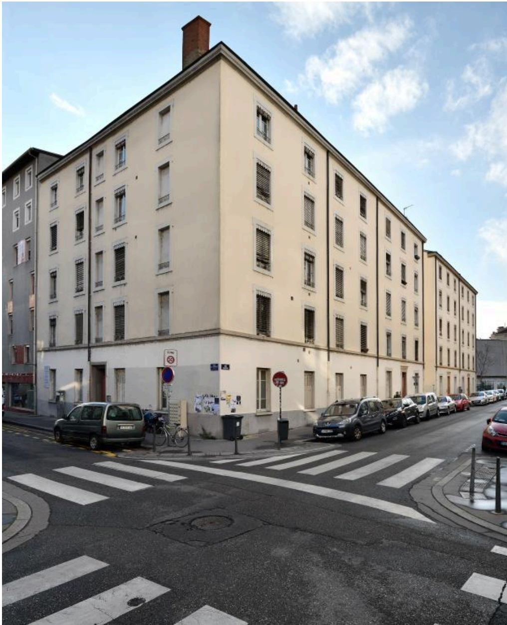
Alignement ouest, rue Pasteur
