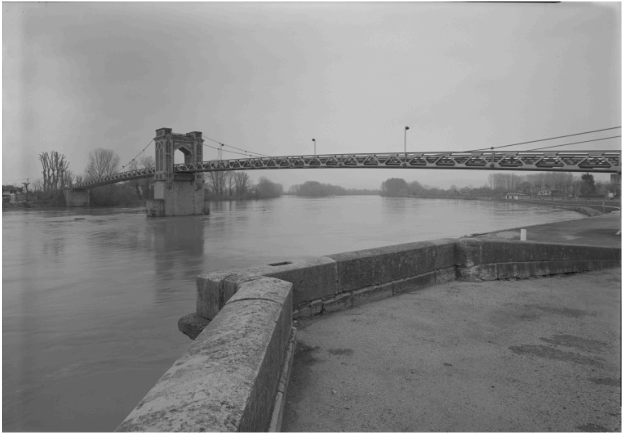
Vue prise depuis le quai, rive gauche.
