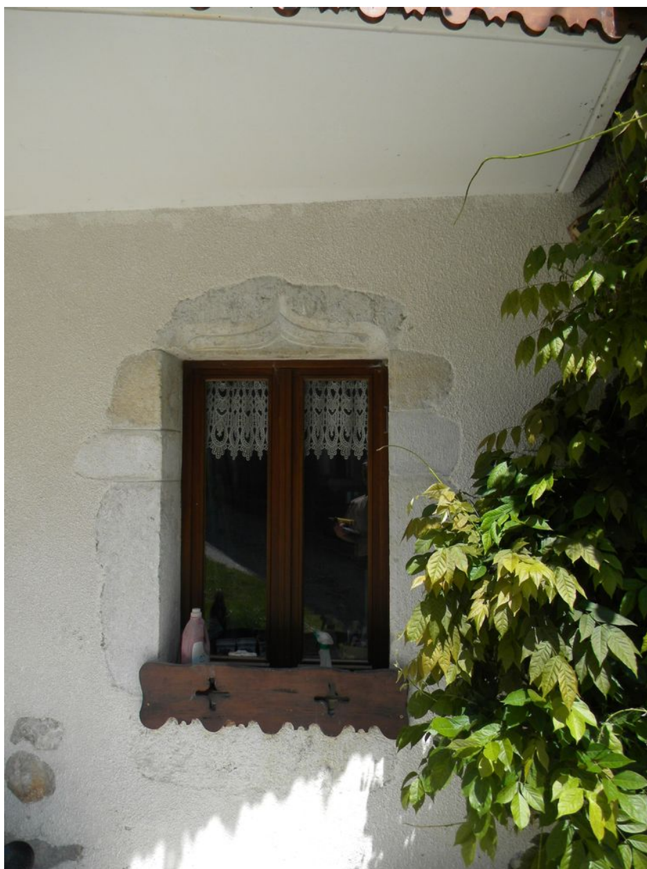
Fenêtre à accolade sur le pignon sud.
