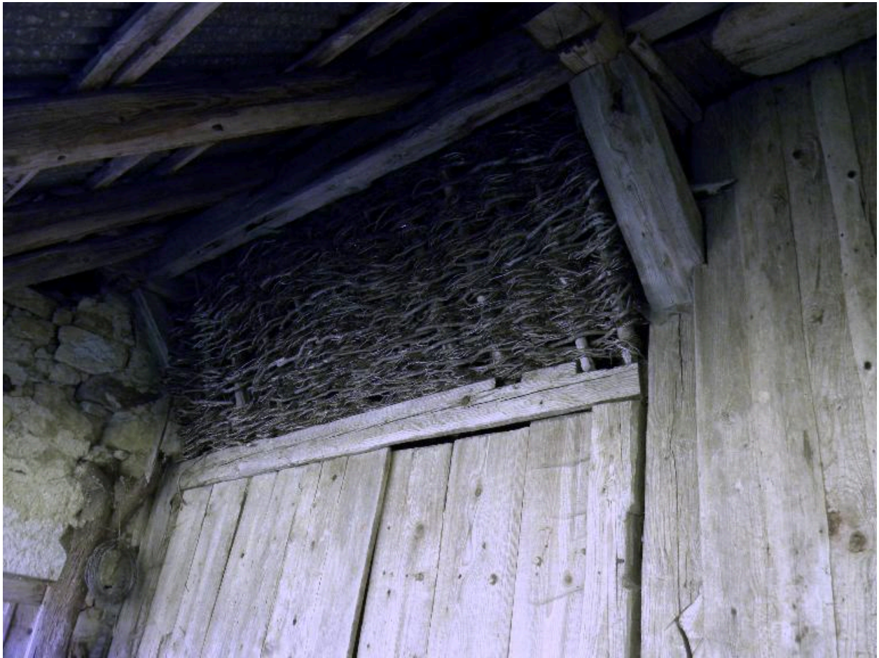
Détail de clayonnage pour aérer le fenil sous le toit.
