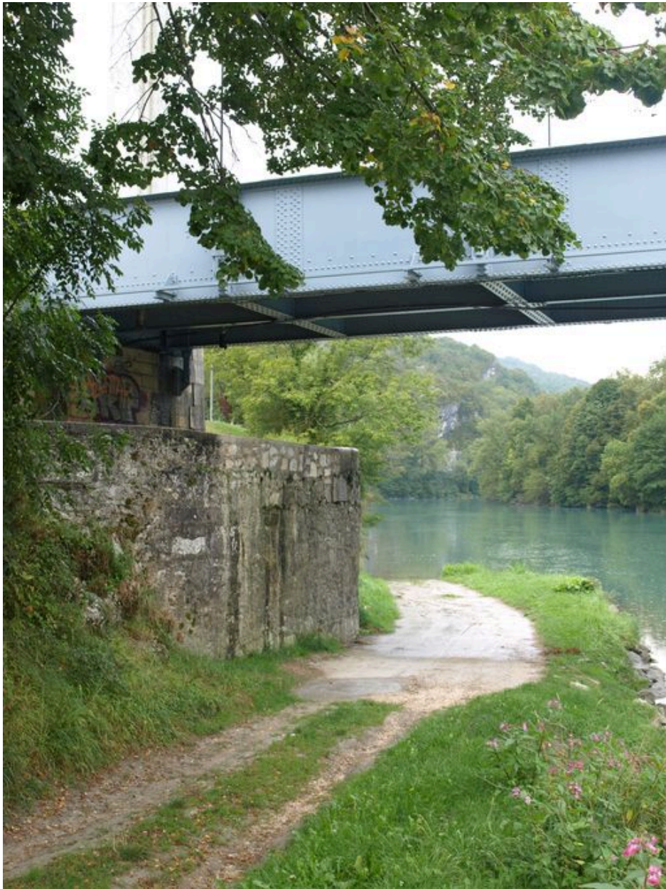
Culée gauche, face amont, vue partielle (depuis la rive gauche)
