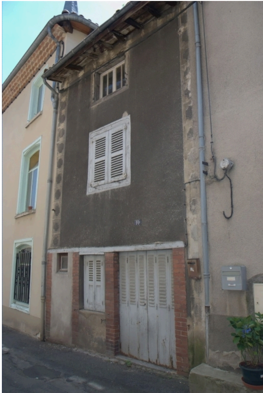
Îlot 6. Veloutiers (rue des) 10. Vue générale de la façade sur le rue.
