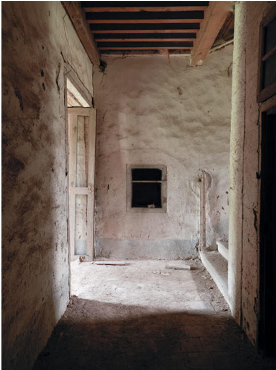
Vue intérieure du vestibule du rez-de-chaussée, depuis le nord.
