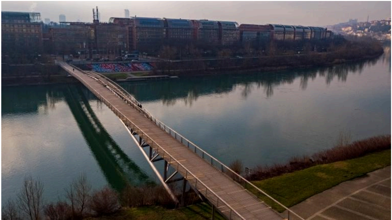
Vue d'ensemble nord-ouest de la passerelle de la Paix et de la cité internationale (drône)
