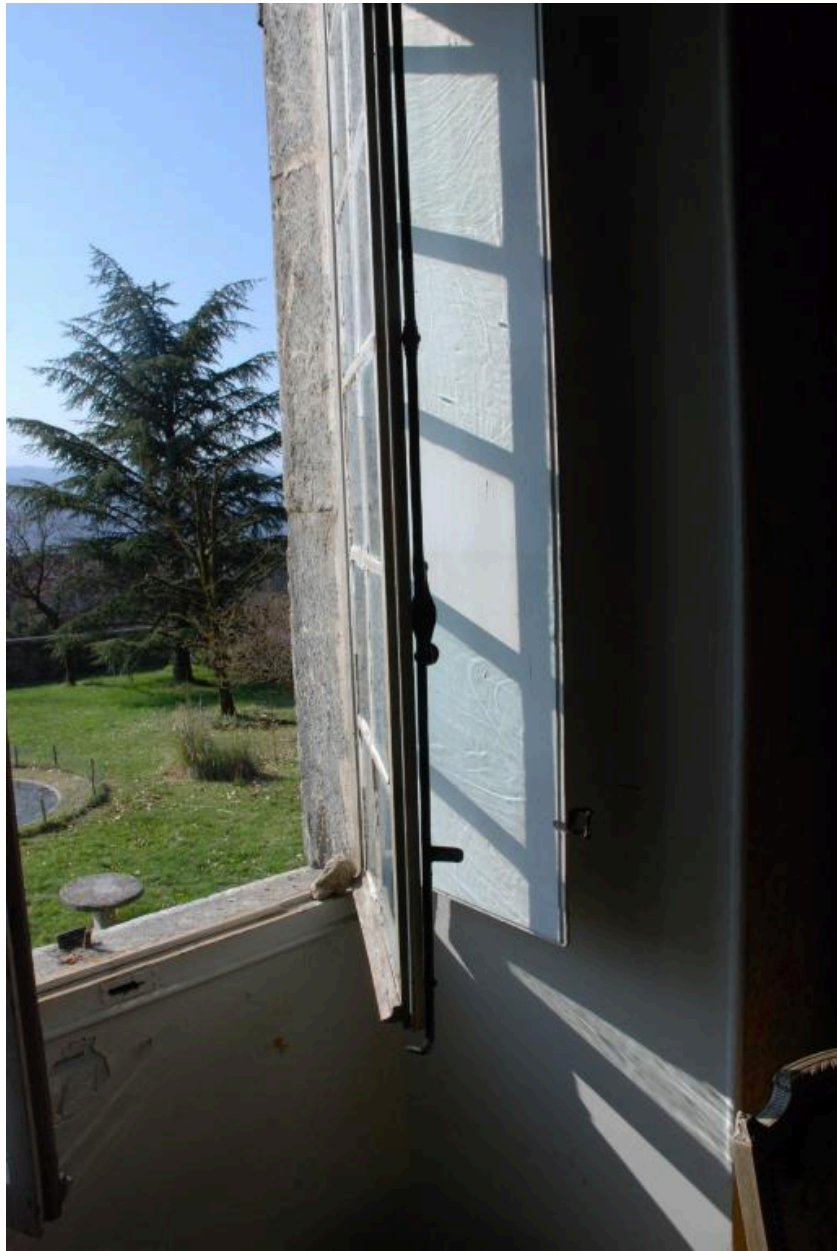
Corps principal, premier étage, partie sud, chambre (Cf. Plan étage 7), détail de la fenêtre.
