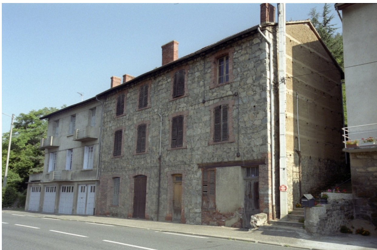
Boën, îlot 19, RN 89, 49. Vue générale de la façade sur rue.
