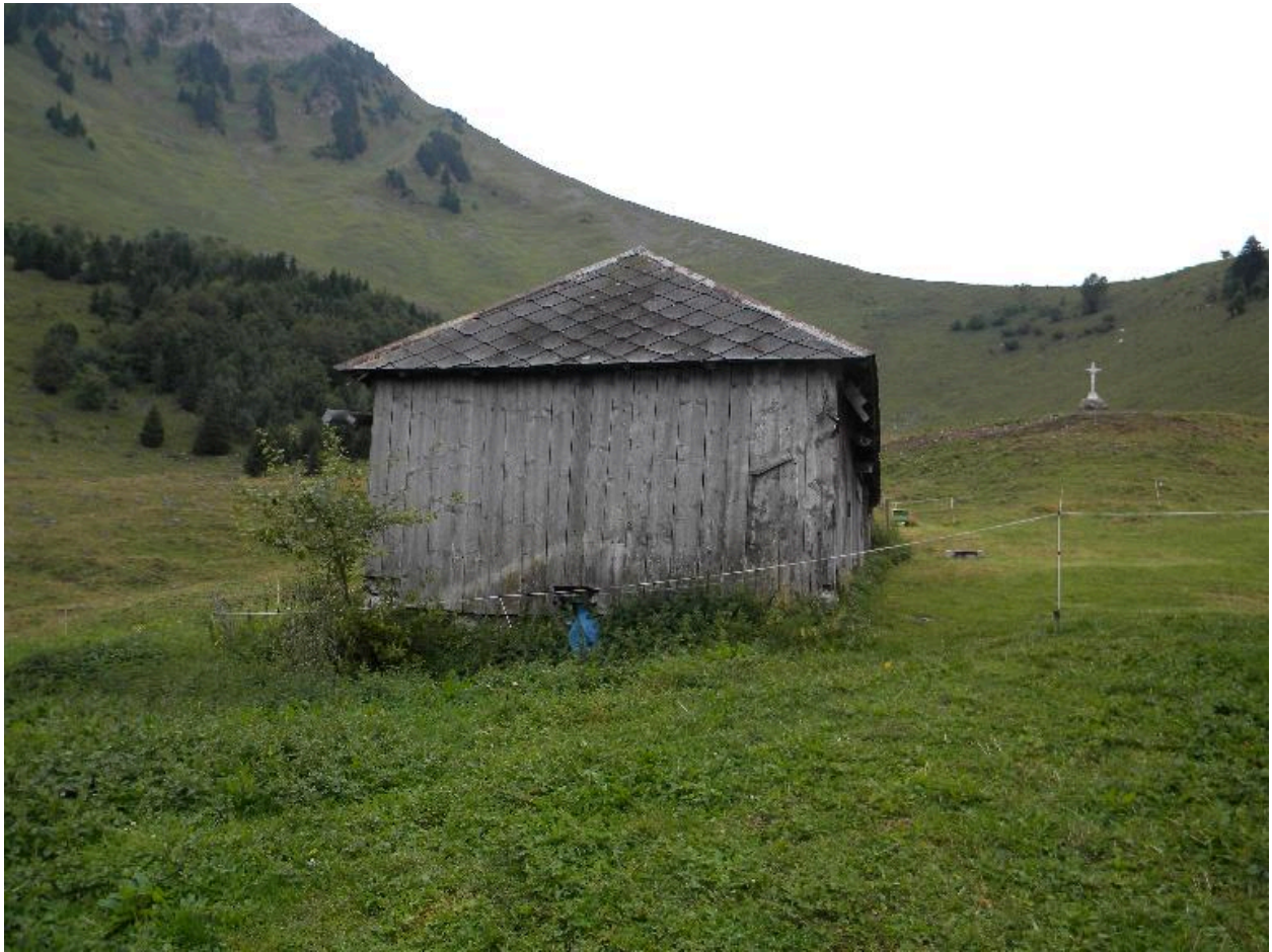
Vue du pignon nord de l'étable est.
