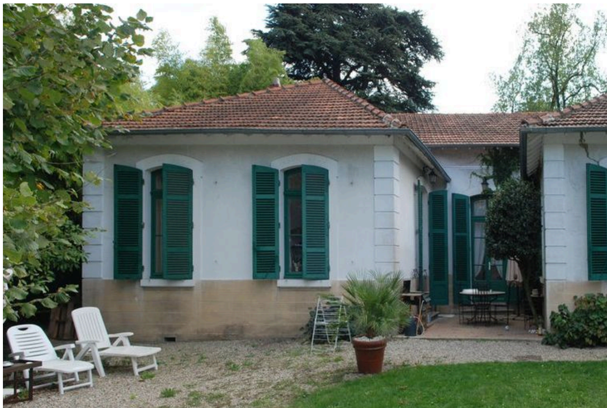
Bâtiment 510, façade postérieure (nord). Détail d'un avant-corps latéral construit vers 1913
