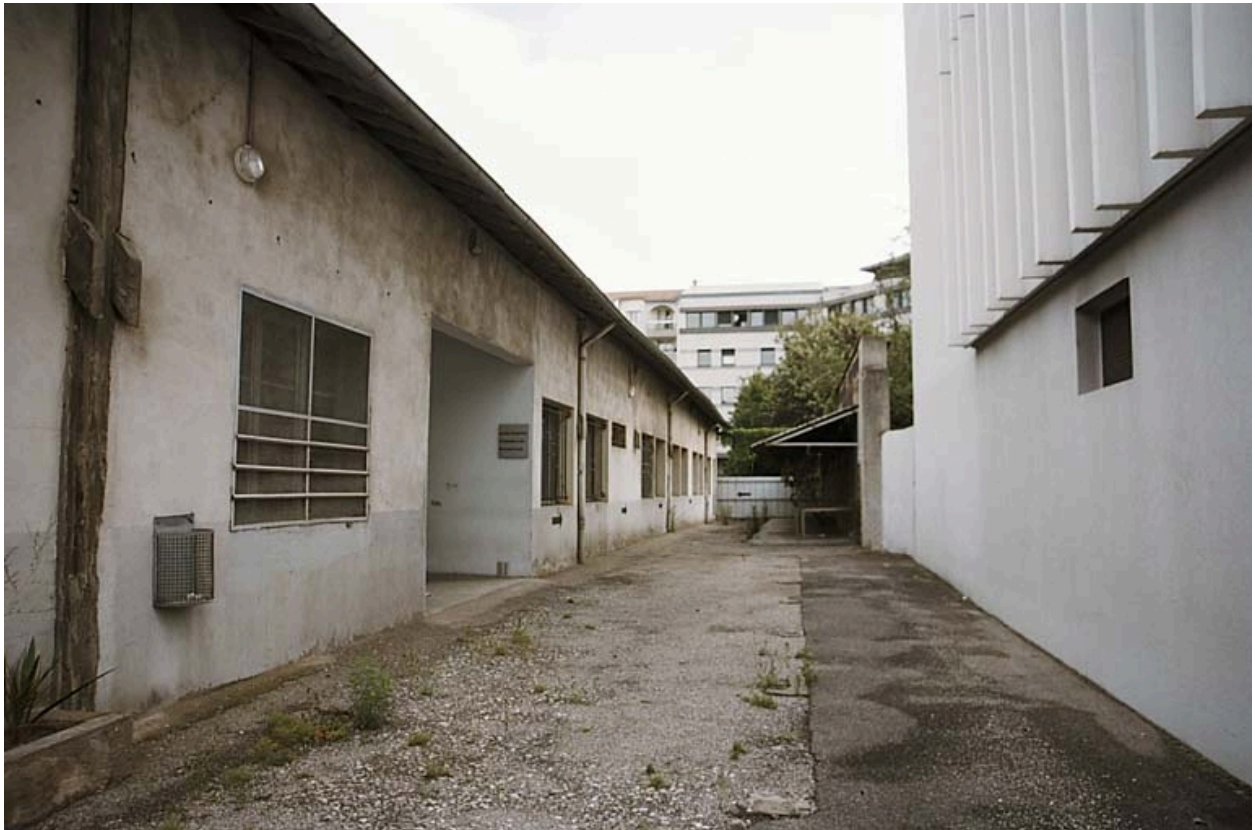
Passage latéral et garage à vélo dans le fond
