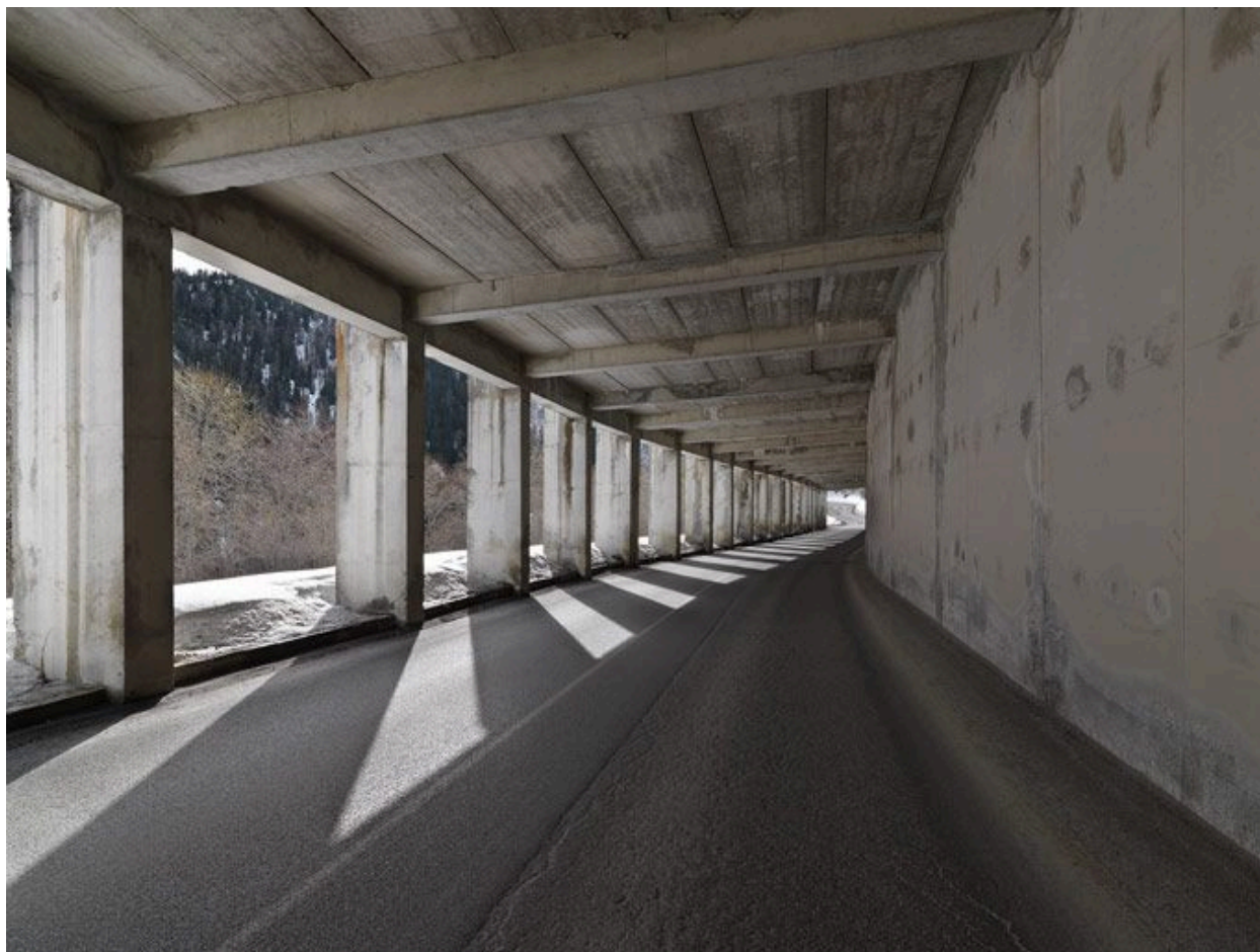
Paravalanche sur la route d'Arc 2000
