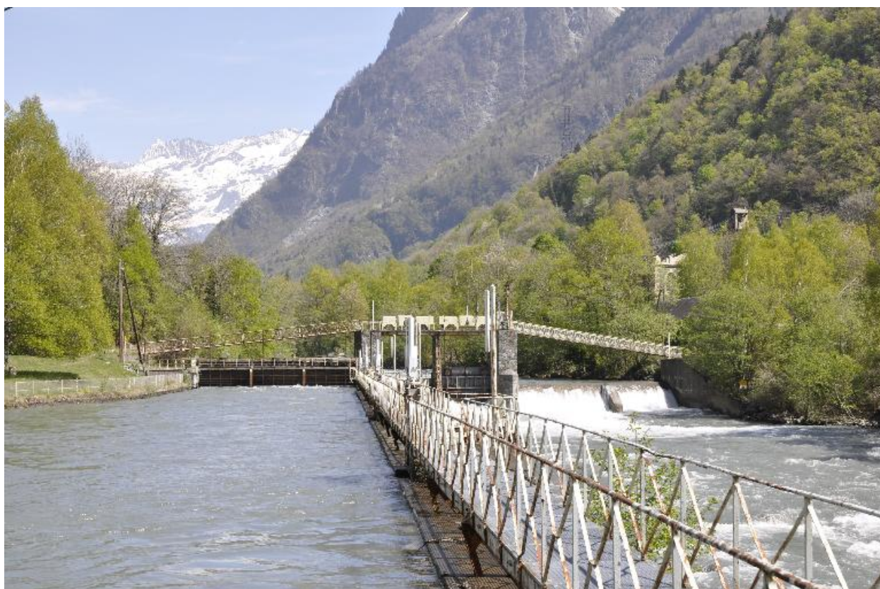
Vue d'ensemble du barrage
