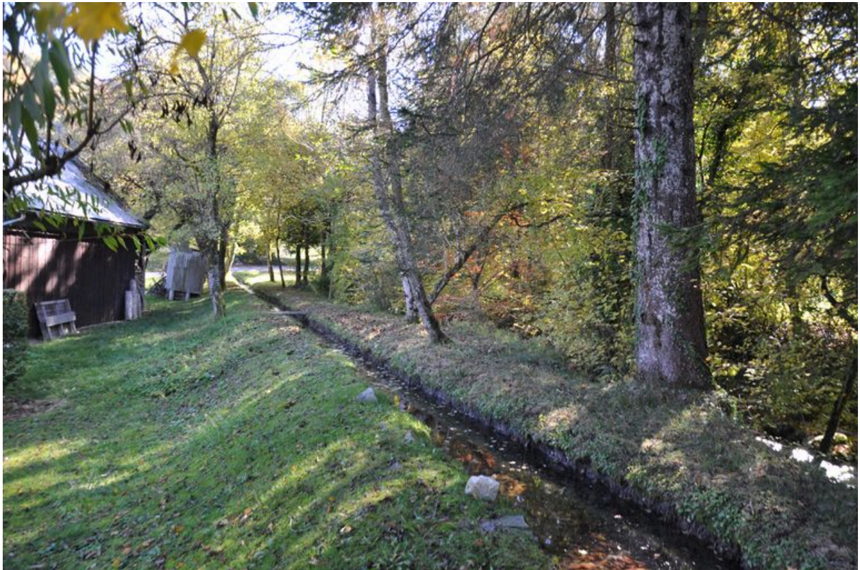
Canal d'amenée composant le jardin sud
