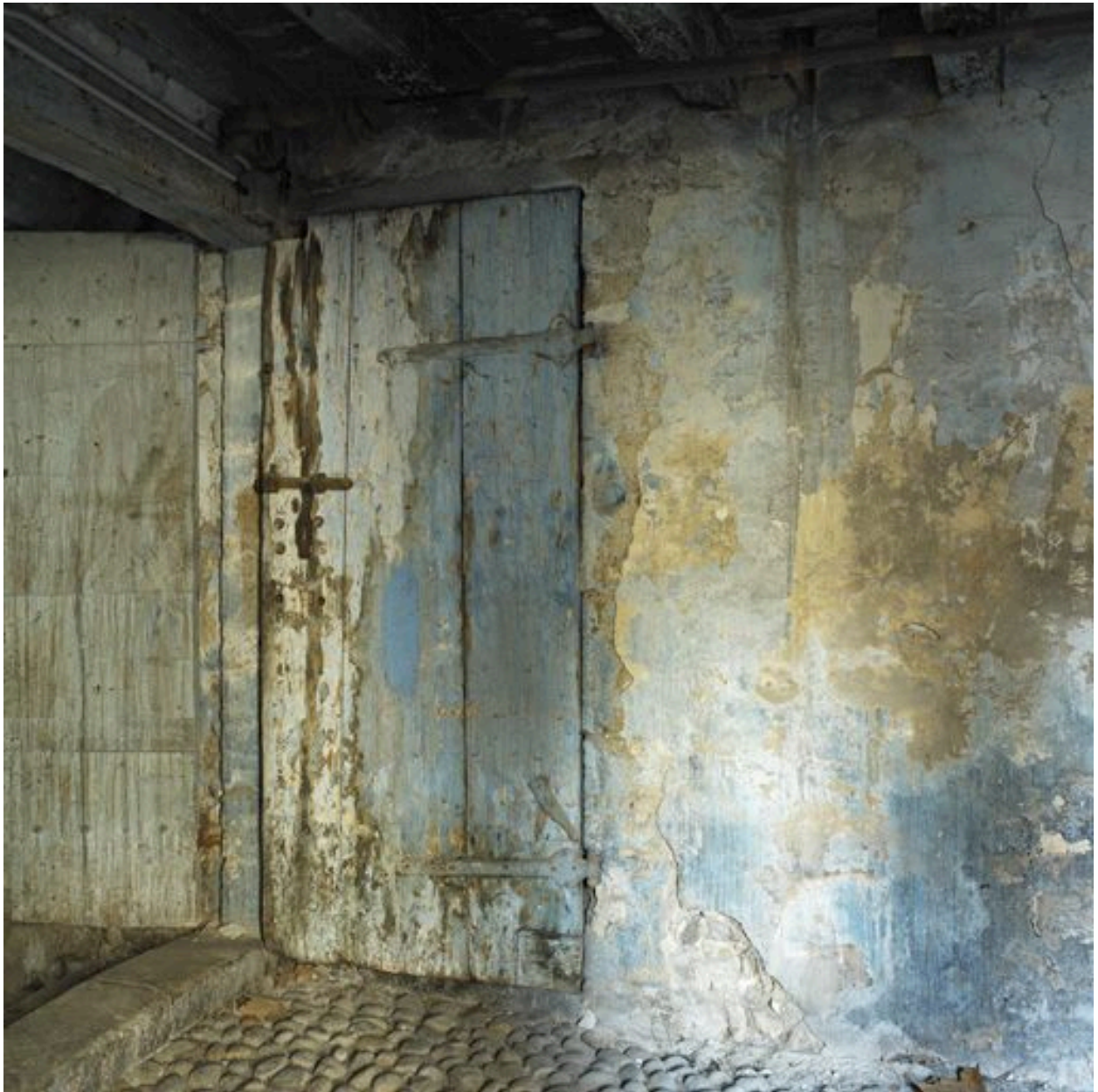
Corps de bâtiment nord. Rez-de-chaussée. Vue des portes d'accès à la tour nord et au corps de bâtiment ouest
