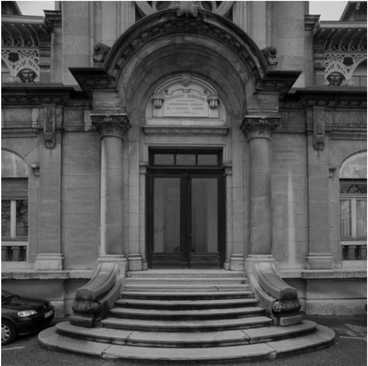
Bâtiment B, façade principale, partie centrale, entrée de la chapelle
