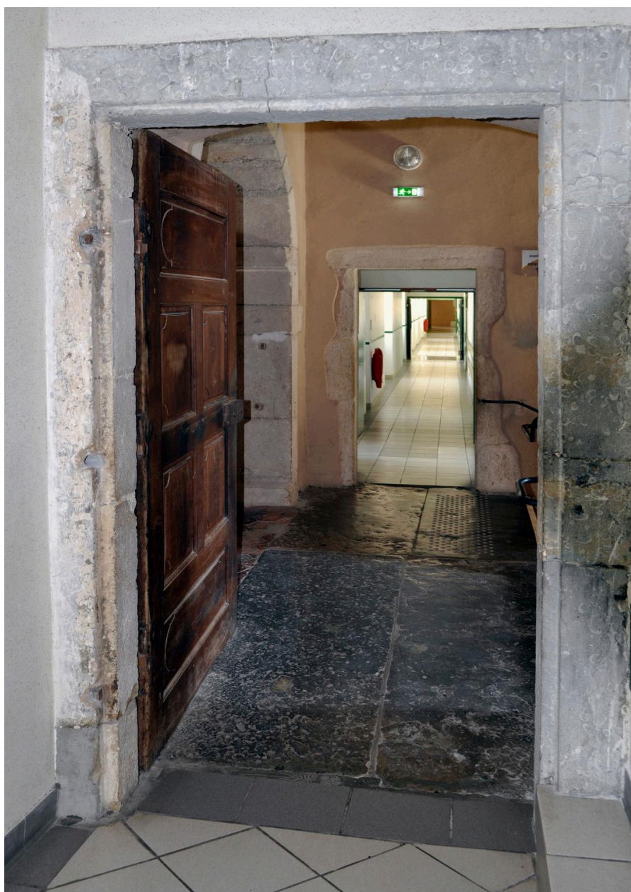
Bâtiment C : palier du 1er étage de l'escalier G et couloir partie nord
