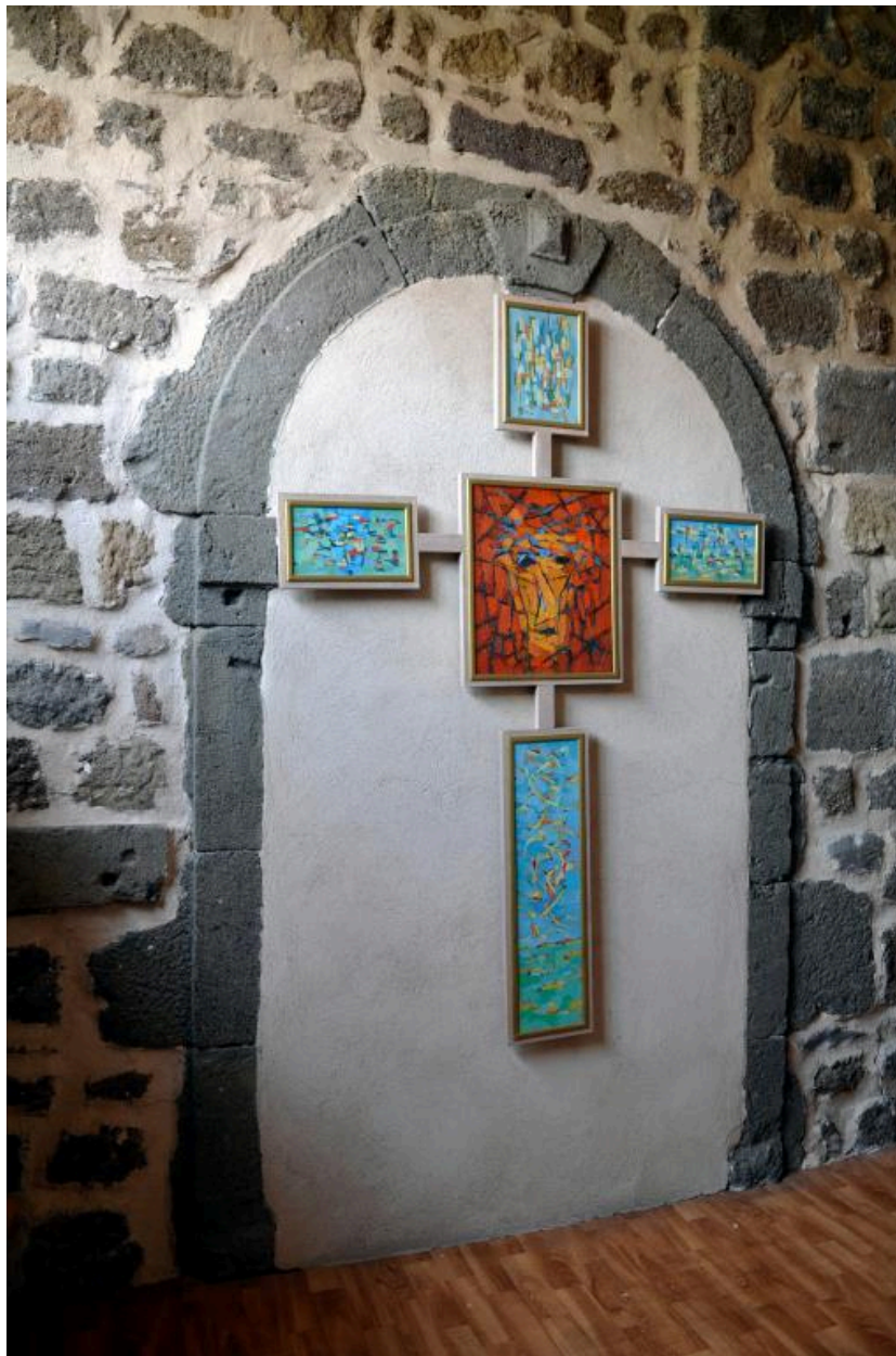
Galerie B, 1er niveau, salle 1 ; ancienne porte communiquant avec le collège, murée
