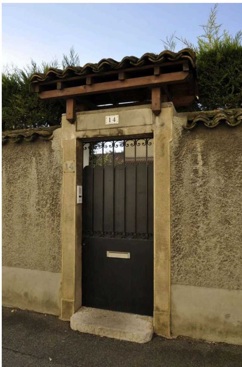
Détail de la porte sur rue
