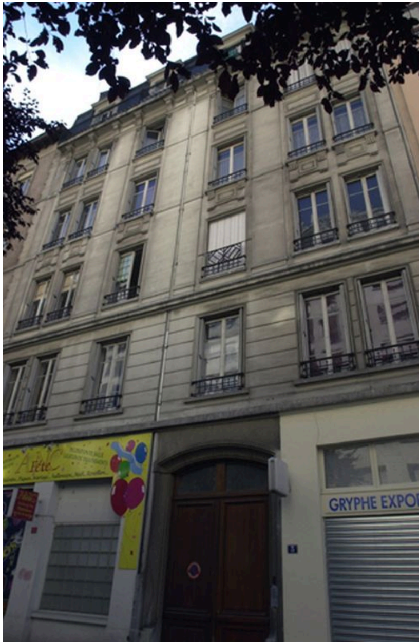
Elévation principale depuis le sud-ouest
