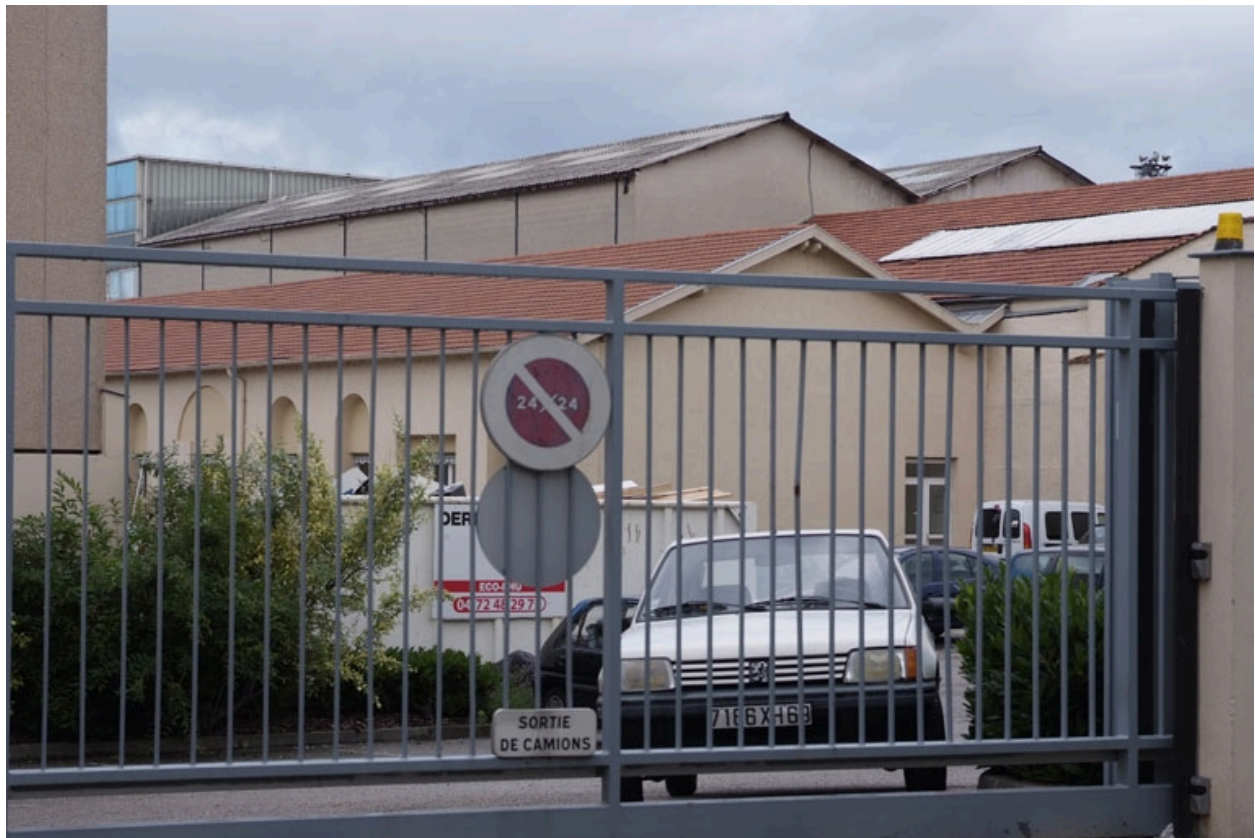
Vue sud (de la rue des verriers)
