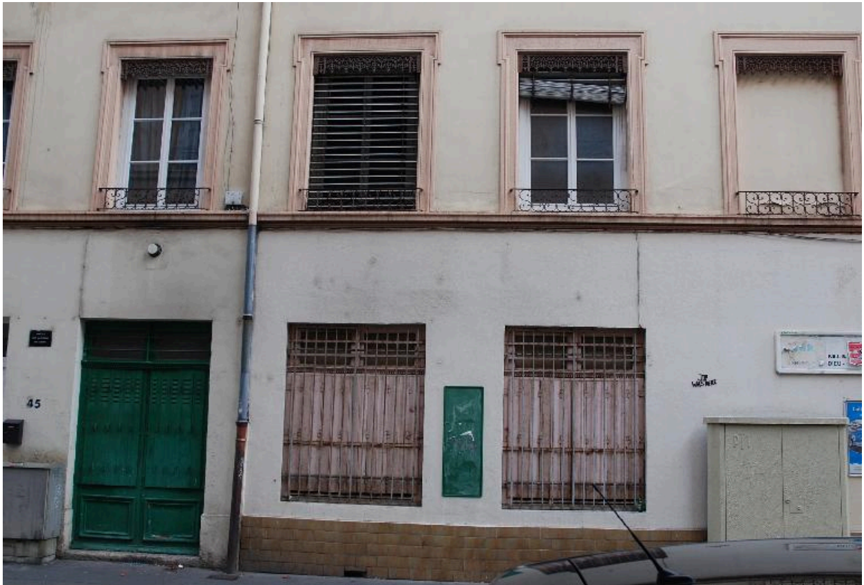
Élévation sud, ancien atelier en rez-de-chaussée (?)
