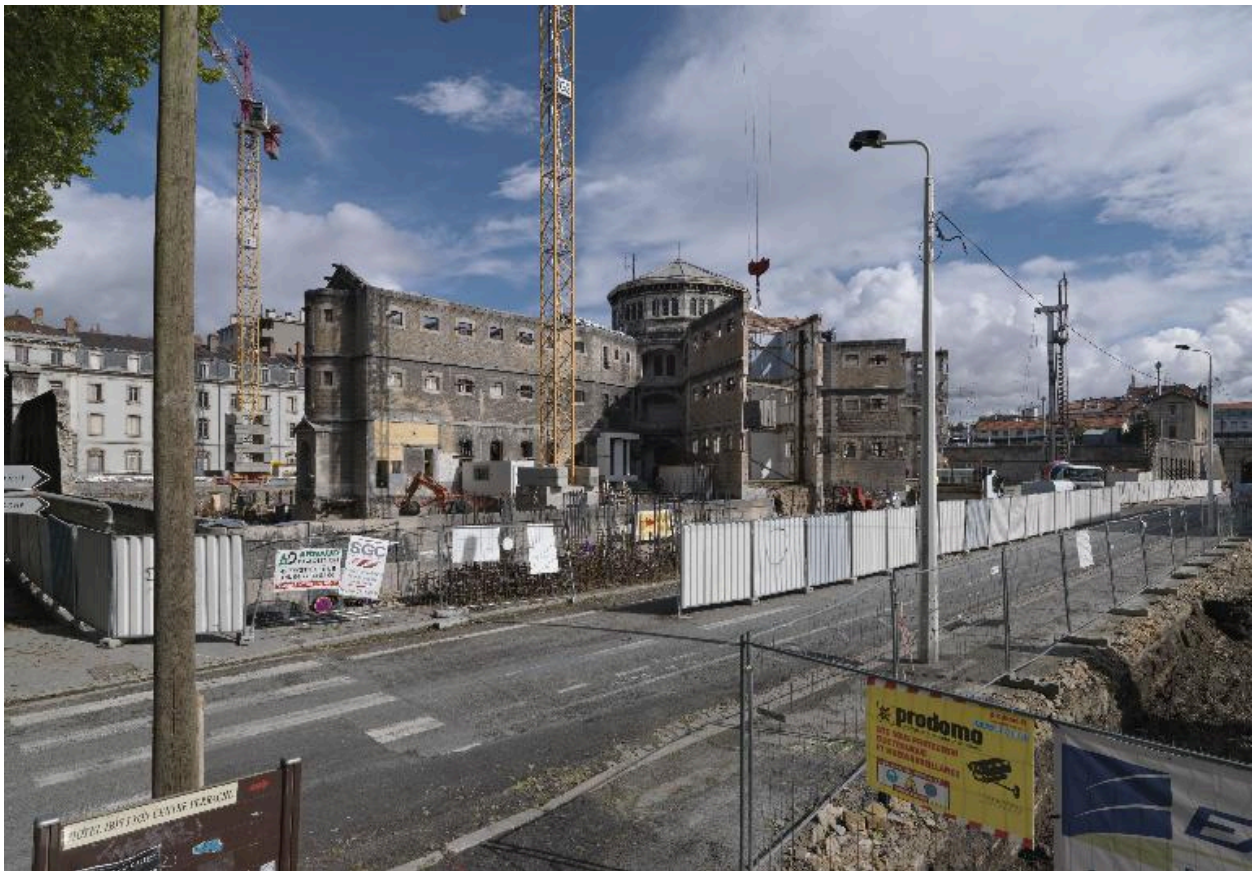
Etat en juin 2013 : vue générale depuis l'angle rue Delandine / cours Suchet
