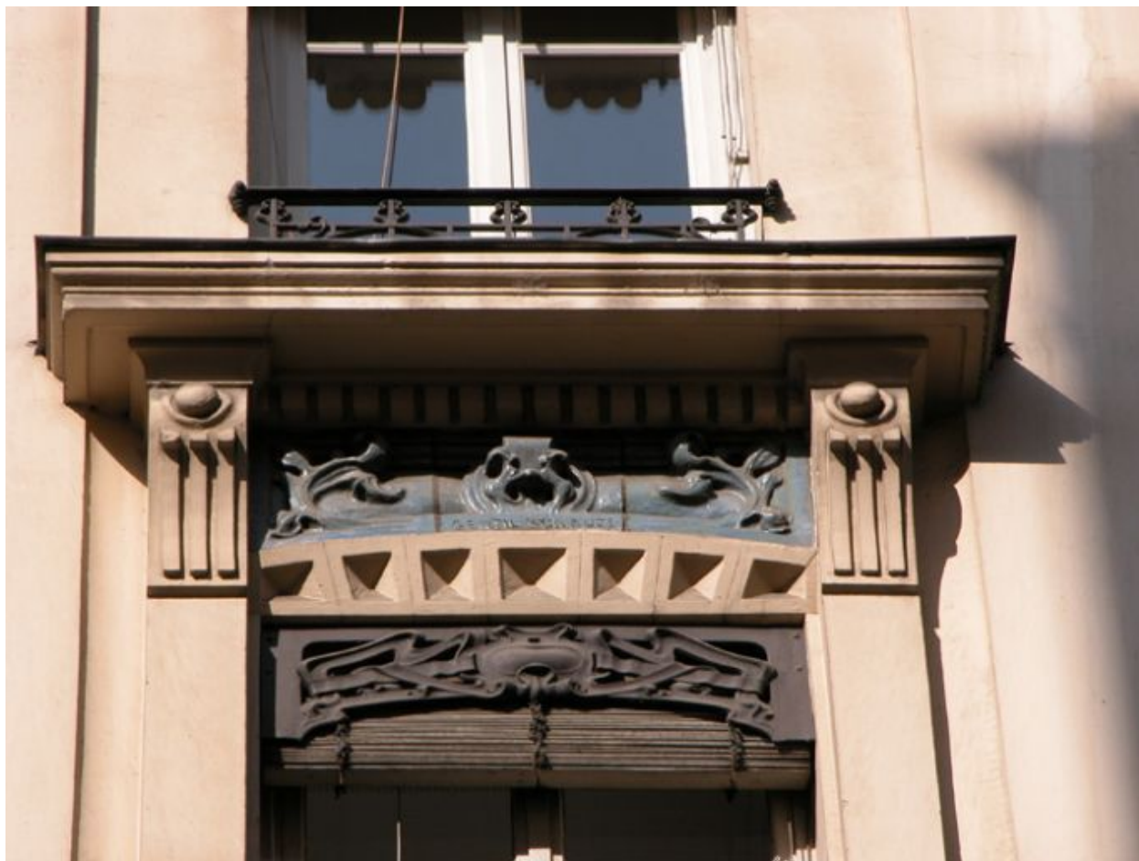
Façade, 4e niveau, détail de la fenêtre centrale
