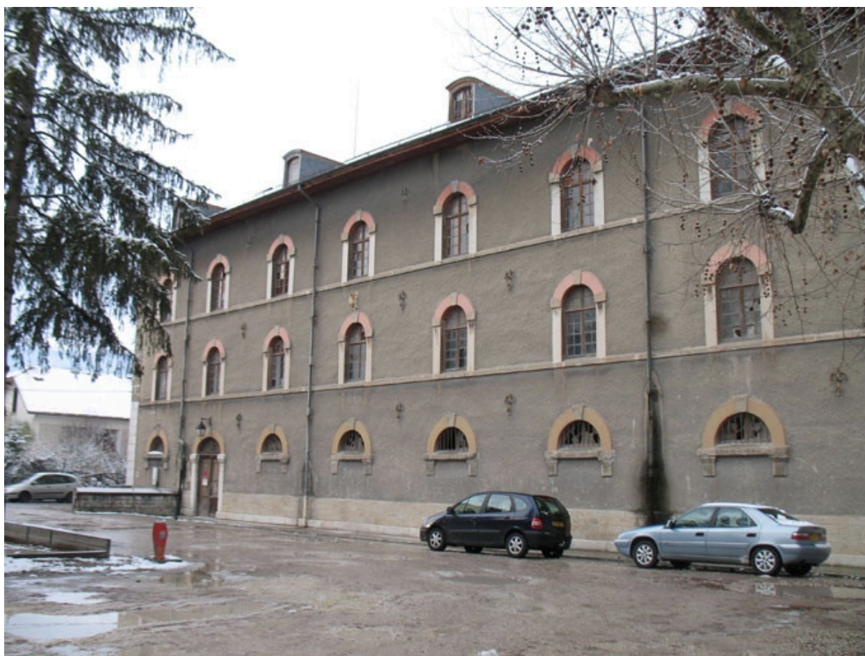
Aile nord qui va être conservée
