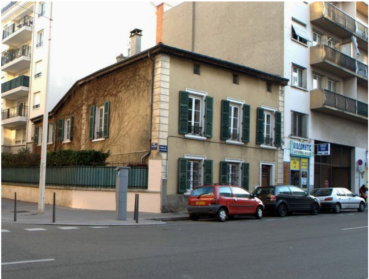
Vue rapprochée depuis le sud-ouest
