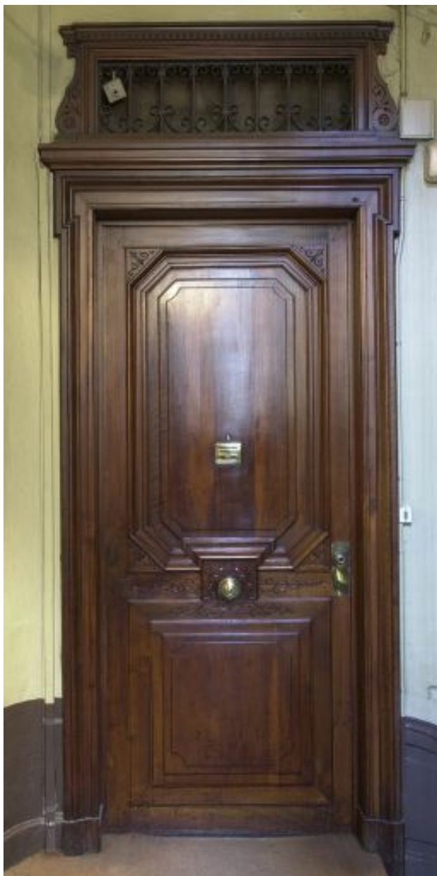
Escalier principal, détail d'une porte palière du 3e étage
