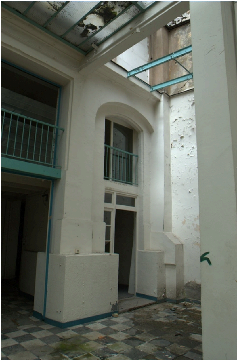
Détail ouverture latérale de la halle
