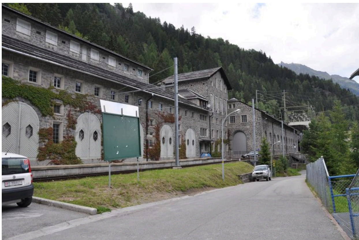
Plate-forme de l'usine CFF du Châtelard
